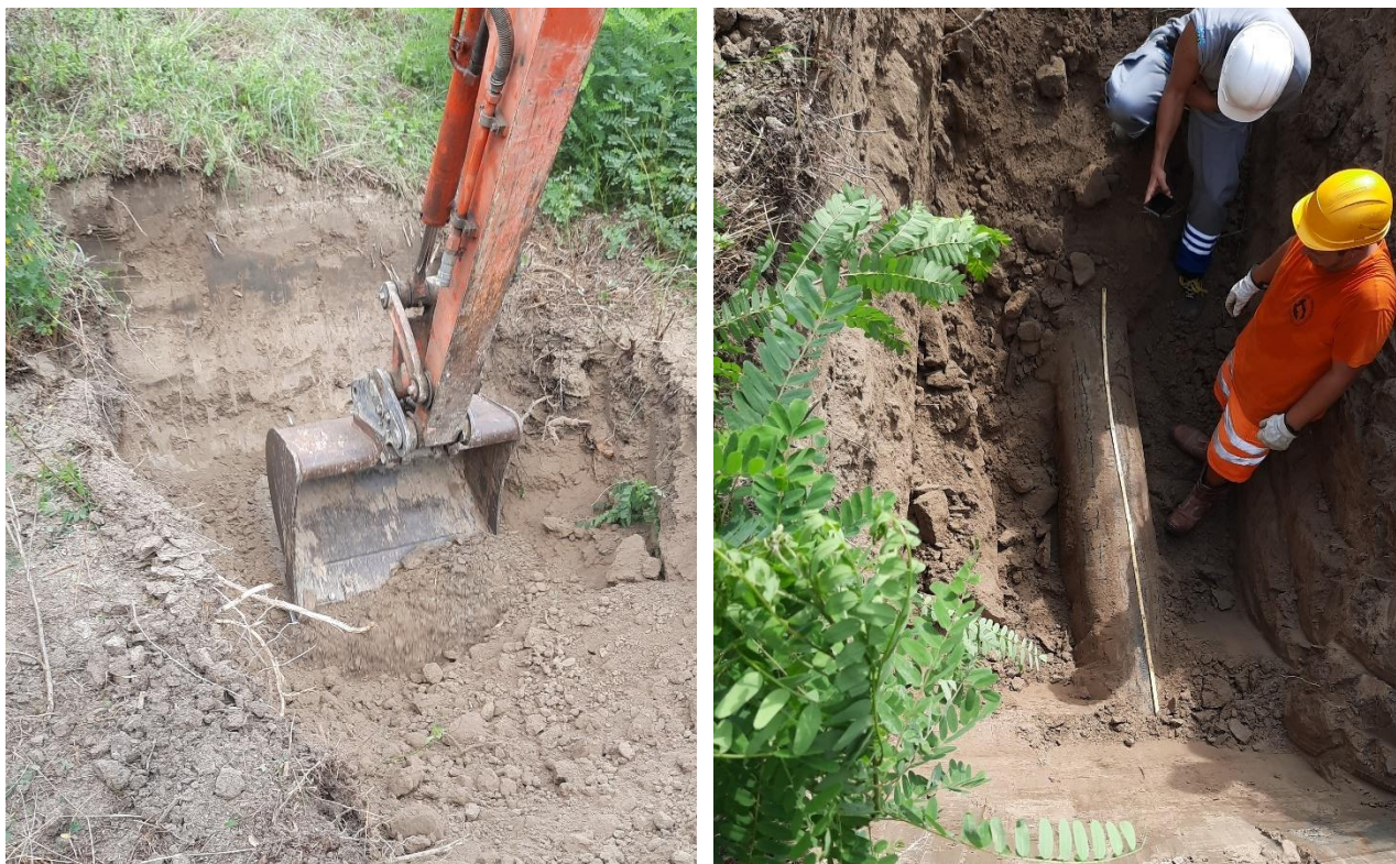
Figura 10 e 11– Saggio eseguito con i tecnici SNAM in corrispondenza dell'attraversamento del metanodotto
